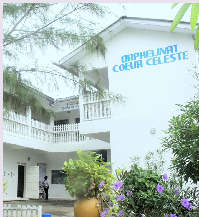
Vue de bâtiment de l'orphelinat
